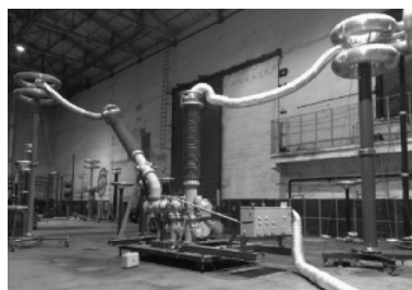
图11 隔离开关小容性电流开合试验 Fig. 11 Capacitive current test of DS
